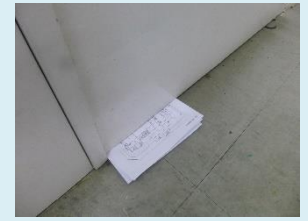
Ảnh 9 & 10: Kiểm tra khe hở giữa cửa chống cháy và sàn nhà Nguồn: khảo sát trước đây của tác giả
