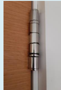
Ảnh 3: Ví dụ về rỉ dầu từ bản lề Nguồn: Diễn đàn an toàn cháy nổ Safelincs
